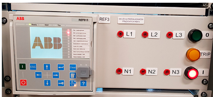
Fot. 3. Front pola z przekaźnikiem zabezpieczeniowym
