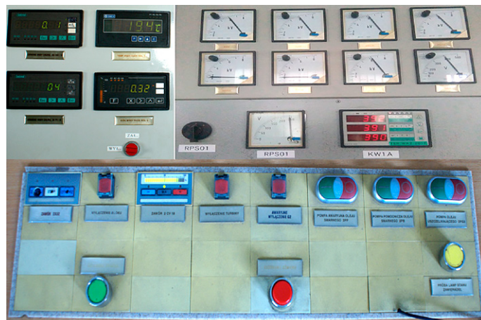
Fot. 1. Fragment dawnej nastawni z aparaturą kontrolno-pomiarową
