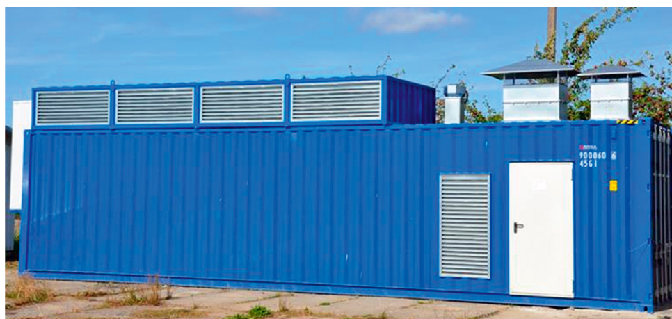
Fot. 1. Widok jednego z kontenerów wchodzących w skład magazynu energii
