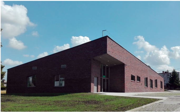
Fot. 3. Ośrodek Zdrowia w Przyszowicach: podwójne źródła odnawialne, tj. fotowoltaika oraz pompy ciepła
