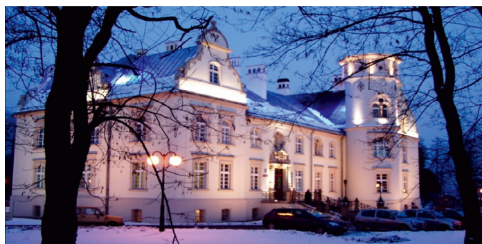
Fot. 2. Zespół Pałacowy Przyszowice z ośrodkiem zdrowia, Urzędem Stanu Cywilnego oraz przedszkolem, odbiór ciepła i energii elektrycznej z biogazowni 370 kW
