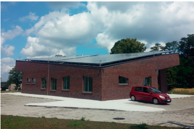
Fot. 4. Ośrodek Zdrowia w Przyszowicach z widoczną fotowoltaiką: 33 kW – 160 paneli
