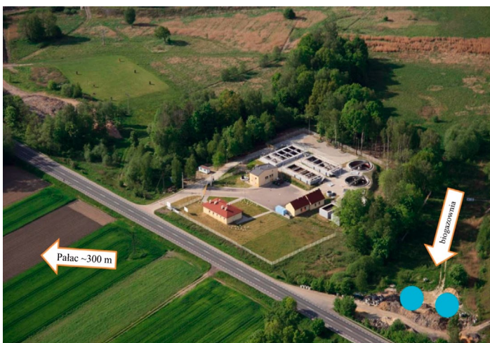
Fot. 1. Lokalizacja oznaczona na niebiesko – projektowana instalacja produkcji biogazu w gminie Gierałtowiec. Widoczna również na zdjęciu istniejąca już Oczyszczalnia Ścieków Gierałtowiec / źródło: opracowanie własne na podstawie: DT Biogazowni o mocy 370 kW
