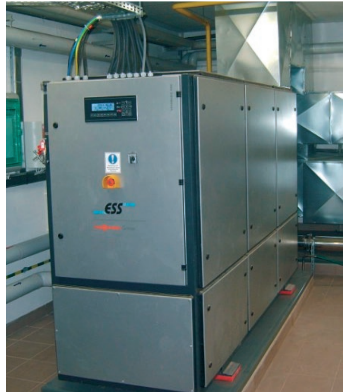
Fot. 1. Widok kotłowni i agregatu kogeneracyjnego 55 kW w minicentrum w Paniówkach
