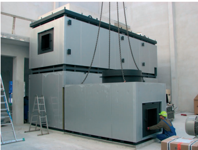
Fot. 1. Montaż paleniska
