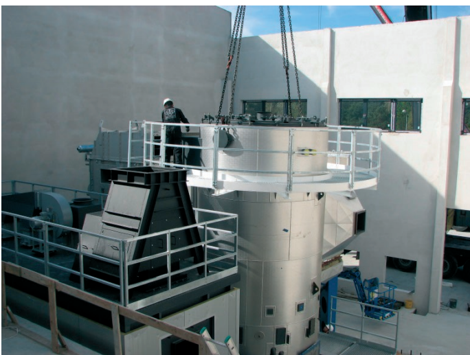
Fot. 2. Montaż podgrzewacza oleju VAS
