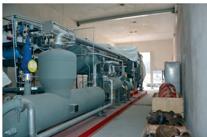
Fot. 4. Turbogenerators ORC ustawiony w elektrowni w Żorach
