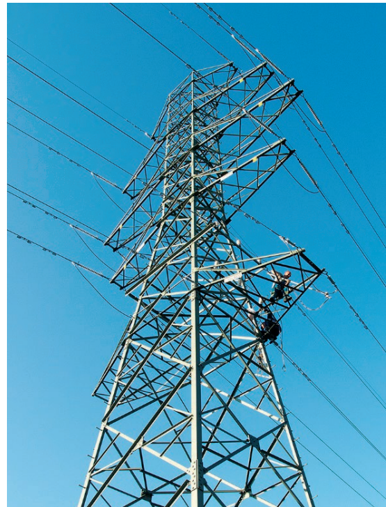
Fot. 1. Słup rozpatrywanej linii na odcinku trójtorowym (dwa toru 110 kV, jeden tor 15 kV)
