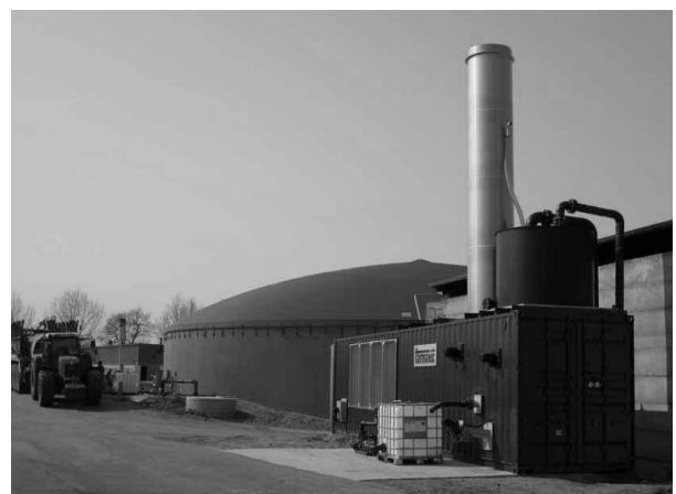
Rys. 4. Biogazownia firmy Farmatic (w Polsce: City Energy)
