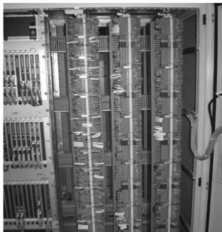
Rys. 2. Przykład poziomu procesowego systemu MASTER (ogniwo, bramka, szafa automatyki)
