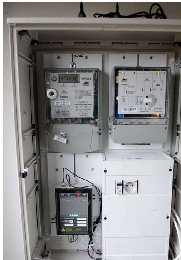
Fot. 1. Szafka z układem bilansującym zamontowana w budynku stacji transformatorowej SWN/nn
