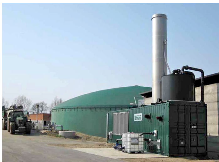
Rys. 9. Biogazownia firmy Farmatic (w Polsce: City Energy)
