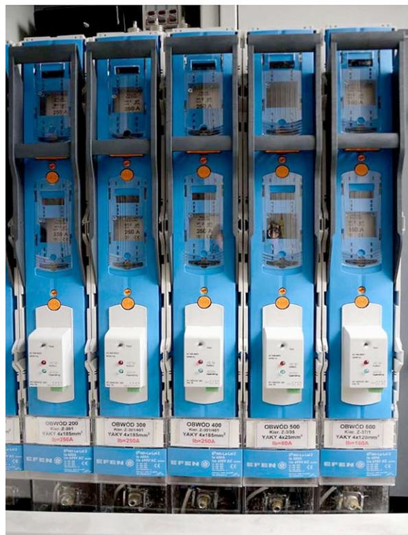
Fot. 3. Przykład rozdzielnicy nn z zastosowanymi sygnalizatorami przepalenia się wkładek bezpiecznikowej – sygnał o uszkodzonej wkładce bezpiecznikowej przekazywany bezpośrednio przez system SCADA do prowadzących ruch sieci
