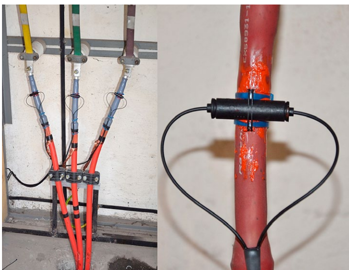
Rys. 2. Przykład montażu czujników optycznych
