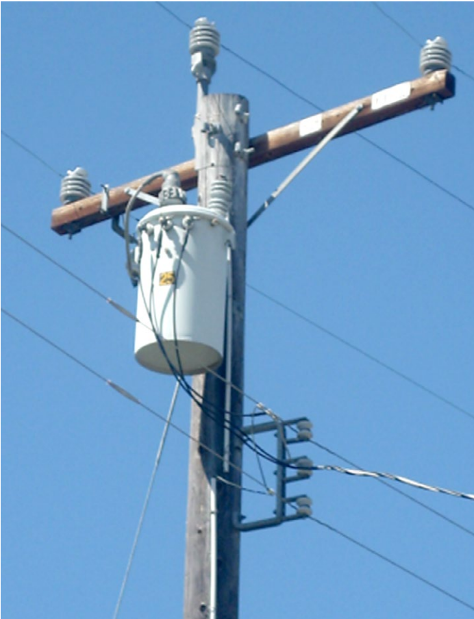
Fot. 1. Sieć rozdzielcza wysokiego napięcia w dzielnicy willowej Danville, nieopodal San Francisco
