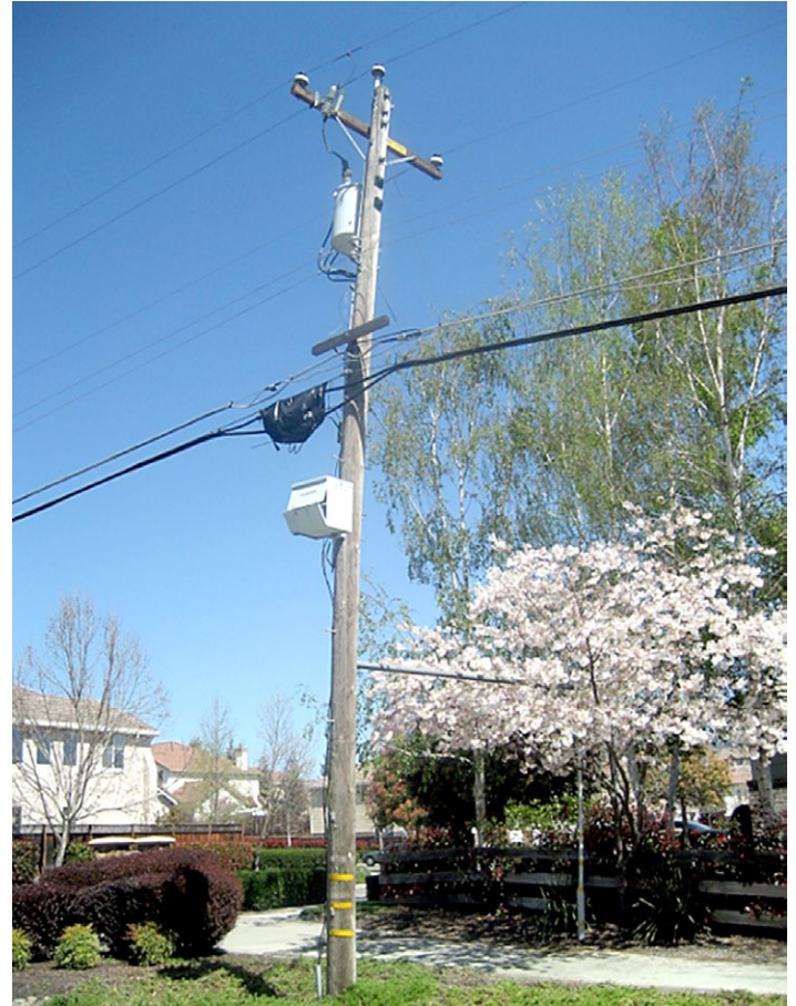
Fot. 2. Sieć rozdzielcza niskiego napięcia w dzielnicy willowej Danville, nieopodal San Francisco
