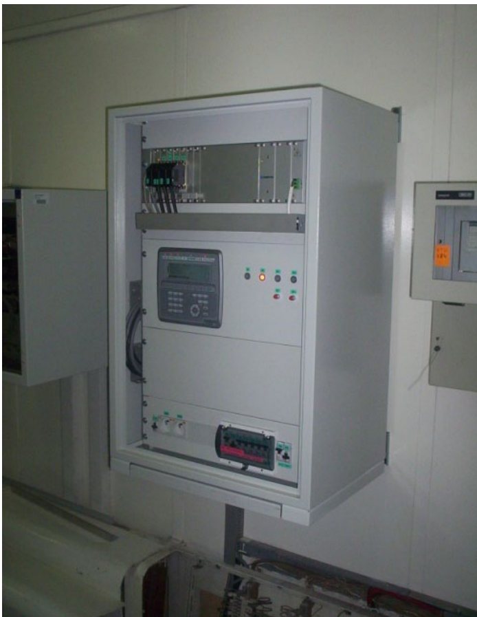
Rys. 2. Mikroprocesorowy elektrohydrauliczny regulator mocy (MREH) konstrukcji OTC
