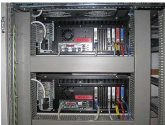
Rys. 2. Przykład poziomu procesowego systemu MASTER (ogniwo, bramka, szafa automatyki)
