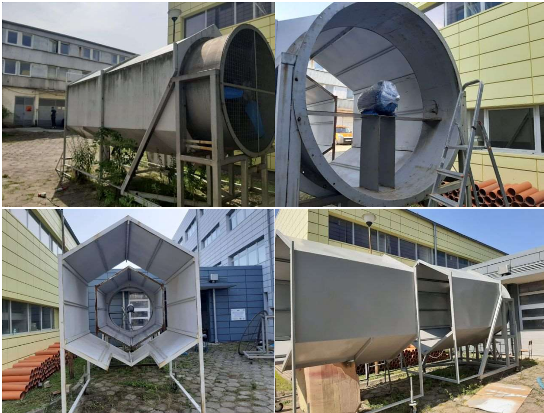
Rys. 16 Prace modernizacyjne przy konstrukcji tunelu (zdjęcia wybrane).
