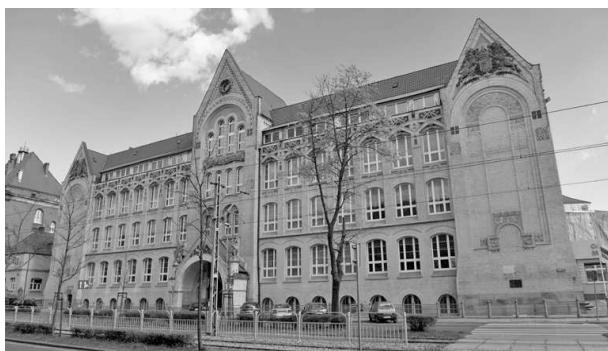
Rys. 3. Aktualny wygląd budynku przy ul. Sikorskiego 37
