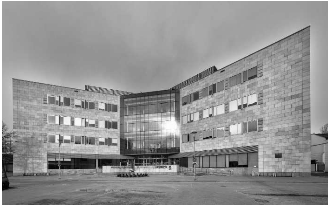
Rys. 2. Nowy budynek WETI oddany do użytku w roku 2008
