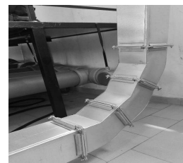
Rys. 2. Układ kolan 3x30°
