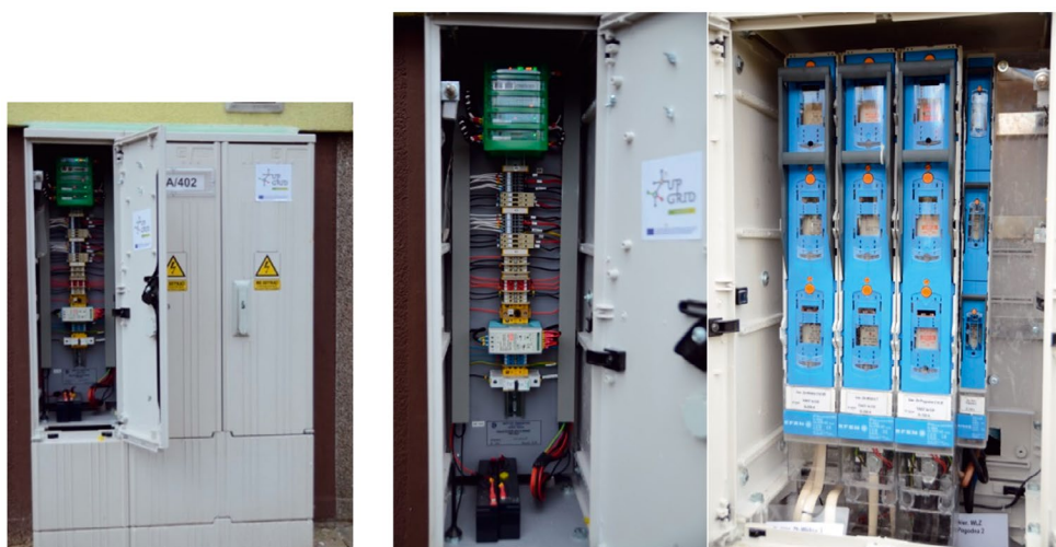
Fot. 2. Złącza kablowe nN z monitorowaniem
