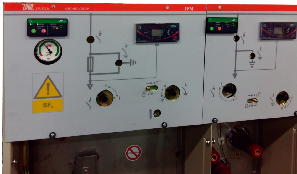
Fot. 1. Widok zamontowanego panelu PAN 1 w rozdzielni PRM
