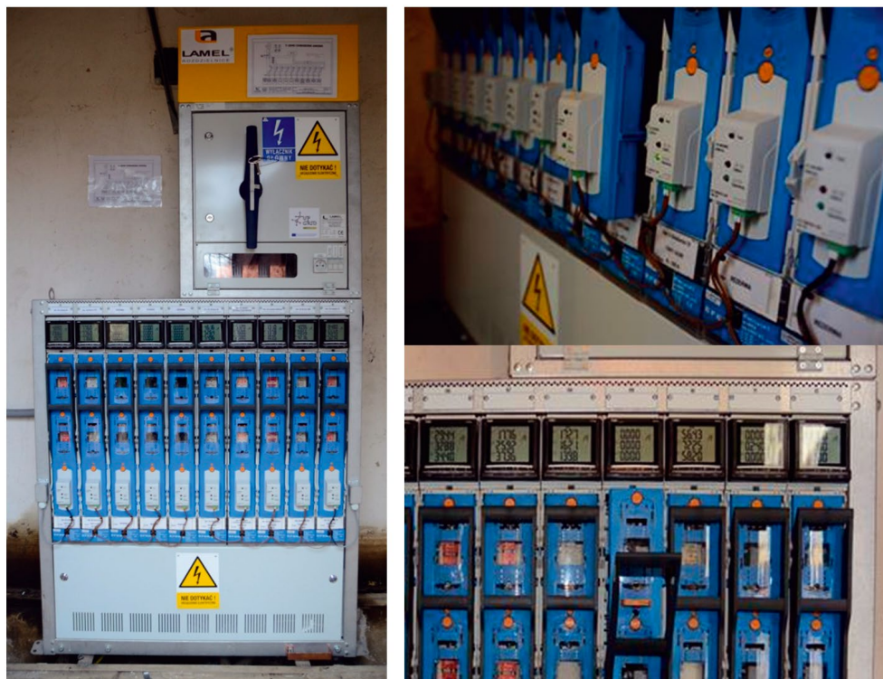
Fot. 1. Rozdzielnica nN z monitorowaniem poszczególnych obwodów nN
