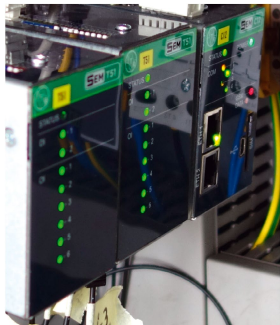
Fot. 2. Dwa moduły akwizycji danych pomiarowych T51, służące do rejestracji danych przesyłanych światłowodem z sensorów
