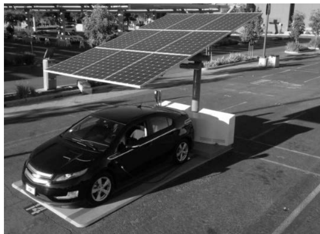
Rys. 1. Autonomiczna stacja ładowania pojazdów zasilana z ogniw fotowoltaicznych [1]
